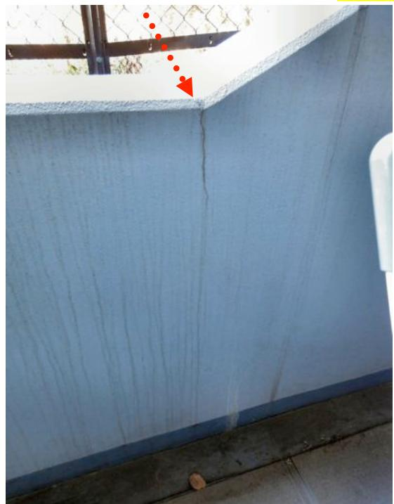
擁壁を”貫通するクラック”から「漏水」と「エフロ析出汚損」発生です。\*爆裂の誘引です。
