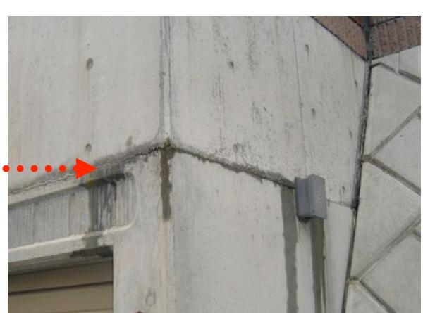
施工当初の打継処置不良が原因の漏水です。
