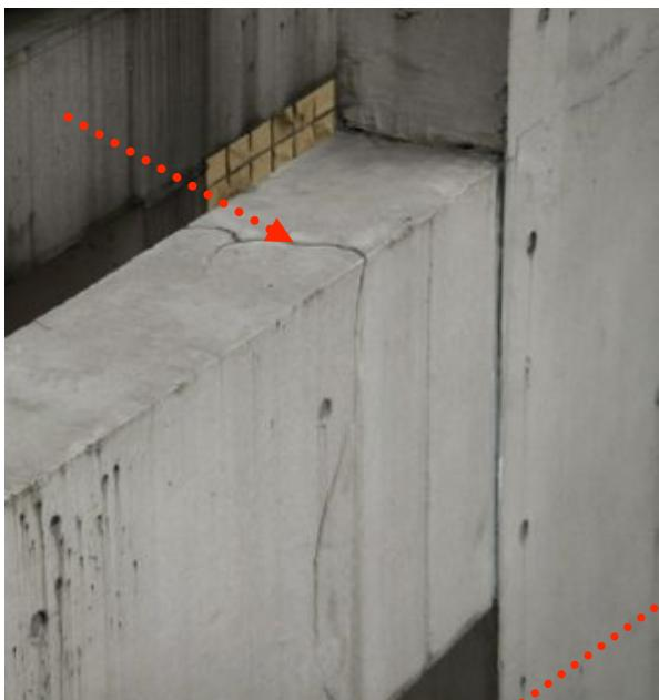
梁躯体を下から見上げます。継続する浸水によるエフロの初期石筍化 \*爆裂への直前誘引です
