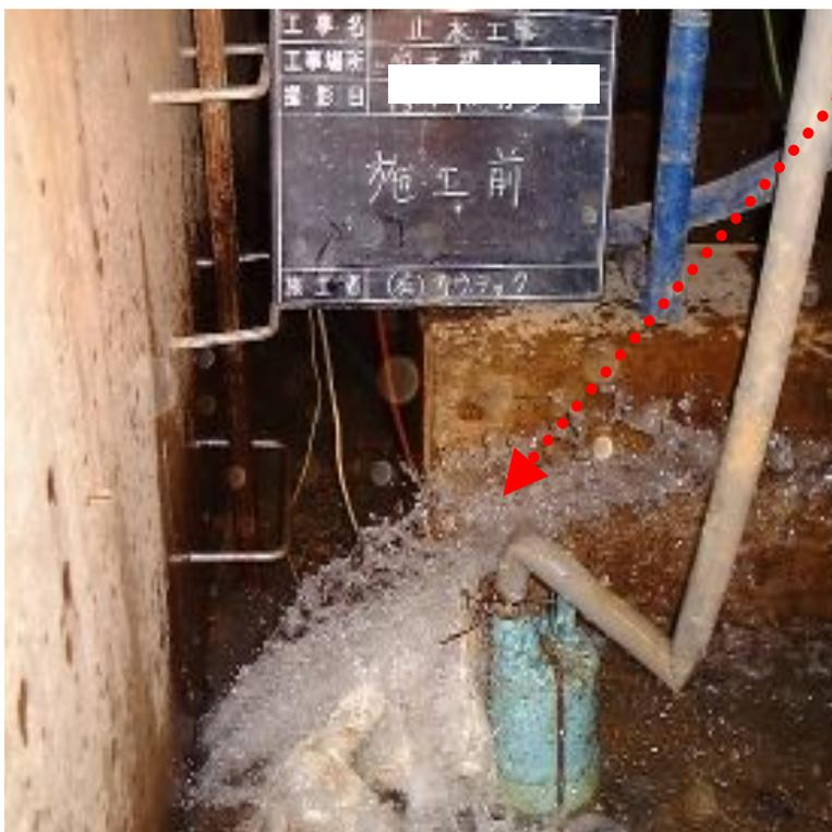
受水槽ピット底盤部からの湧出漏水現象です。
