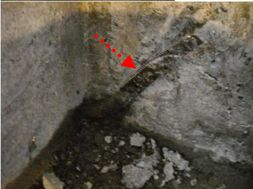
壁躯体に混入した雑物＝”のこぎり”をハツリ取り、躯体を補修し止水・防水処置致しました。
