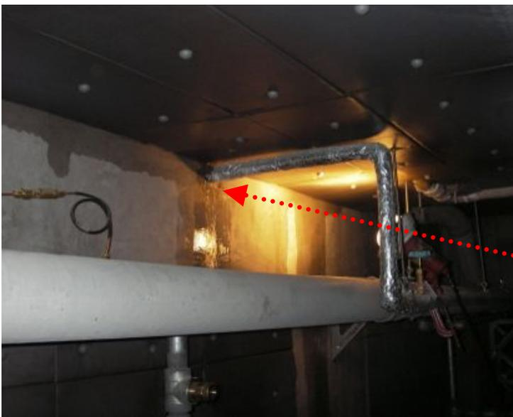
地下壁躯体を貫通する配管スリーブ部の防水施工不良が原因の漏水現象です。
