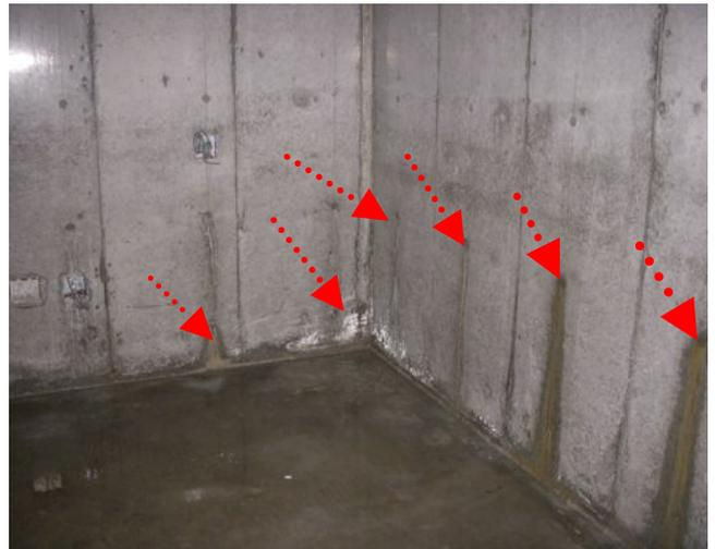
地下室付き住宅の新築工事で、居室になる地下室への漏水が多数確認された事例です。
