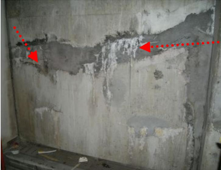
地下壁躯体に発生した、新築工事時のコンクリート打設不良＝コールドジョイントの補修不良が原因となった経年後の漏水現象です。この後に続く現象は、内部鉄筋の発生に伴う躯体爆裂損傷です。
