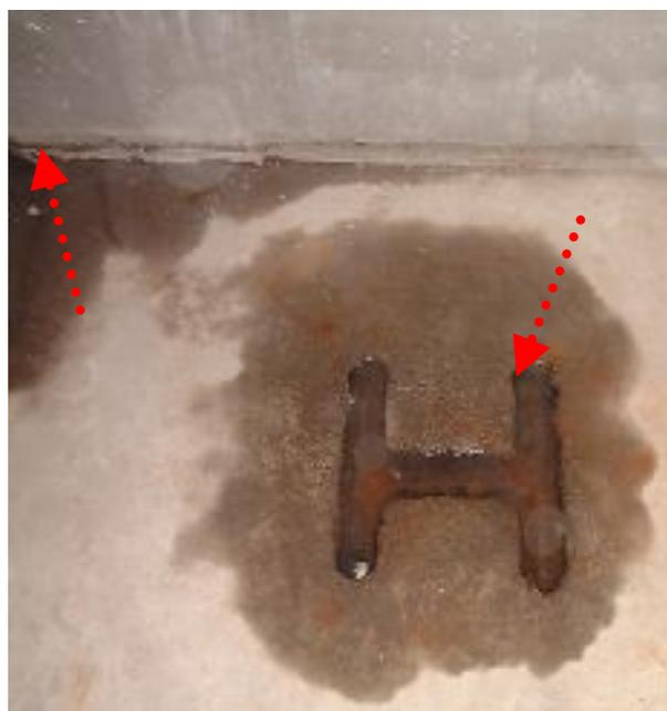
新築工事時の乗り入れ構台用H鋼の溶断跡からの湧出漏水と耐圧版と壁躯体打継部からの漏水現象です。
