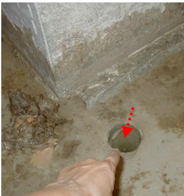
新築工事時に使用した単管地足場の撤去跡からの湧出漏水です。
