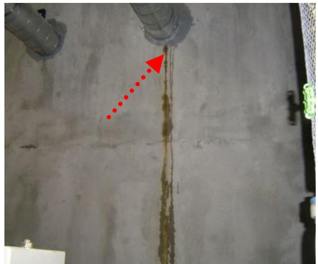
7. 地下壁躯体の新築工事時の打設不良部を正しく補修しなかったために起きている漏水
