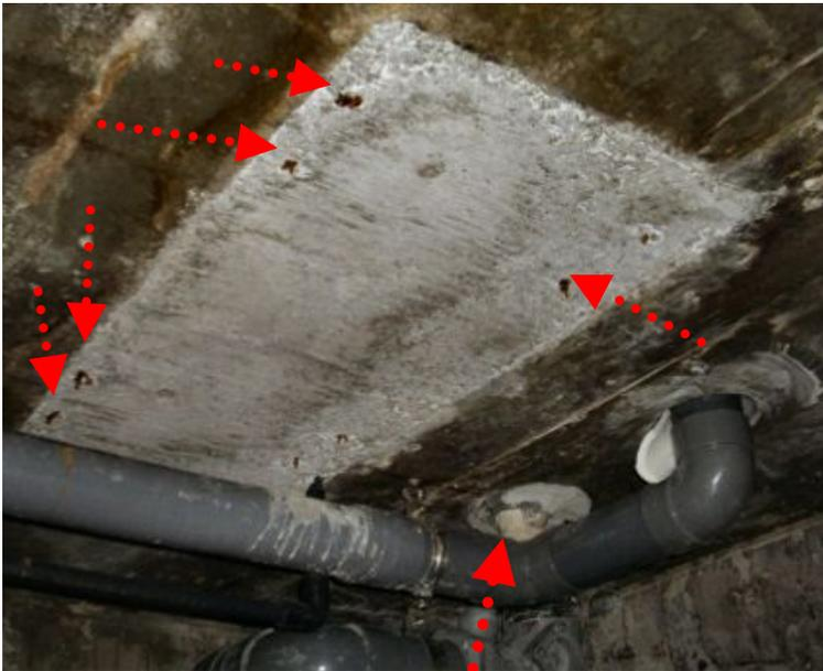
新築工事時に使用した仮枠搬出用開口部を塞いだ後の鉄線を始末しない放置された、手浮き不良工事跡です。
