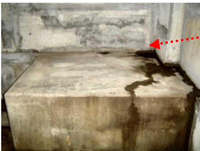
地下ピット内の打継からの漏水現象です。
