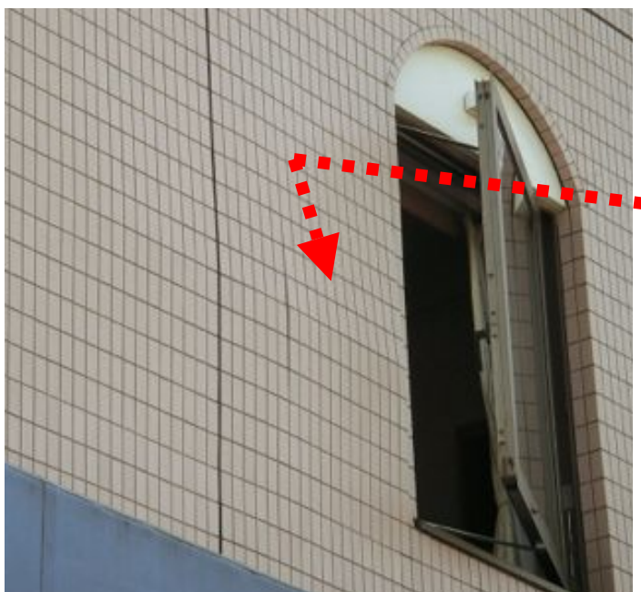
剥離落下直前の外壁タイルです。
