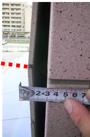
剥離落下直前の外壁タイルです。
