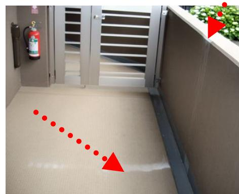
\*共用廊下の長尺シートと手摺壁には、エフロレッセンスの汚れが付着し、シートの交換に至ります。
