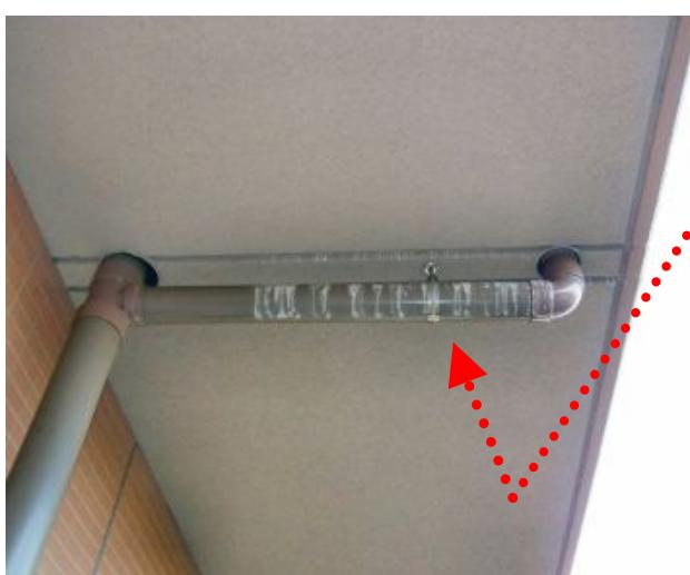
共用廊下天井スラブの誘発目地が貫通クラックとなり上部のウレタン防水層不良部を介して継続して漏水している状態
