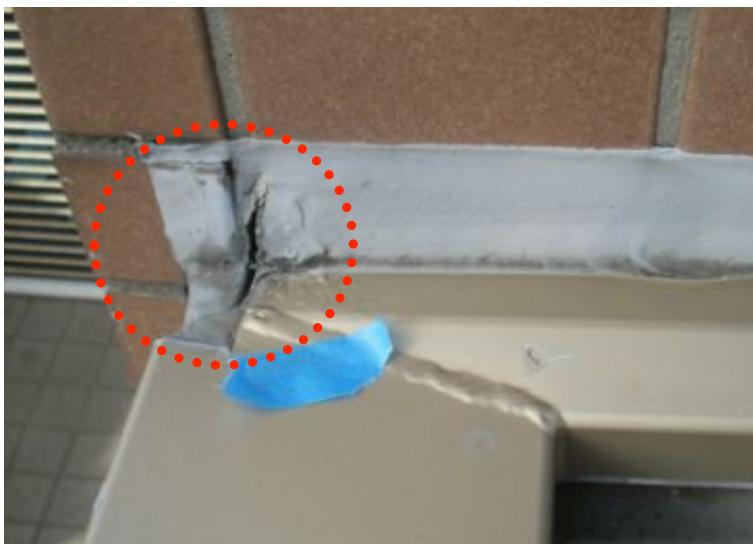
シールの劣化＝破断により内部へ浸透した雨水が下部及び外壁側へ漏水とエフロ析出汚損を起こしている。
