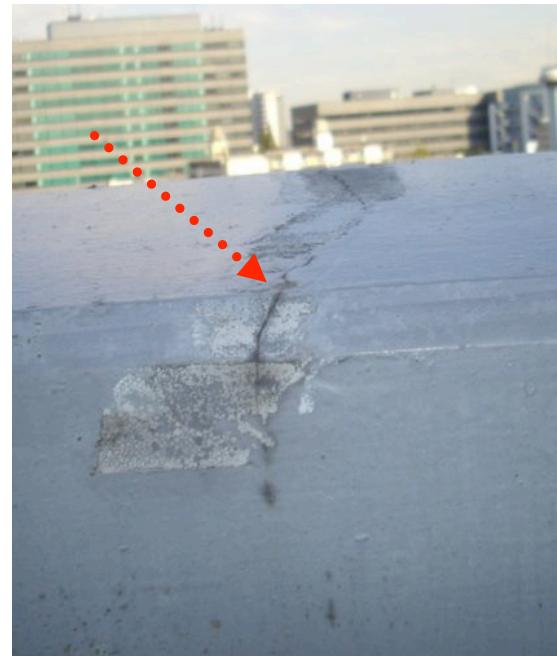
バルコニー手摺壁躯体に発生するクラックです。手摺の天端面等に発生し、雨水等の浸水によりエフロレッセンスの析出汚損から内部鉄筋の爆裂損傷に至ります。
