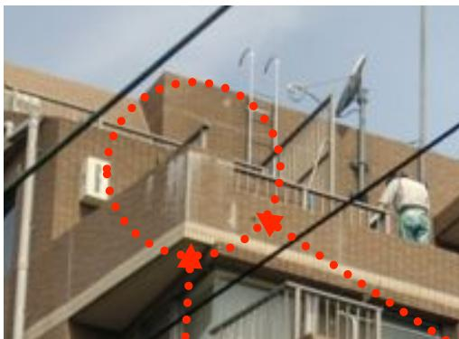
①梁躯体のモルタルに浮きが発生し雨水が侵入
