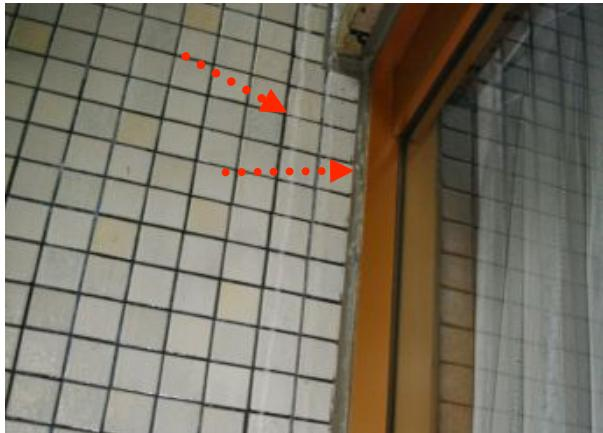
写真の状態は、シール裏側への浸水原因である上部の漏水を止めずにいたため、室内側壁と窓枠下面台への漏水を起こしていた。
