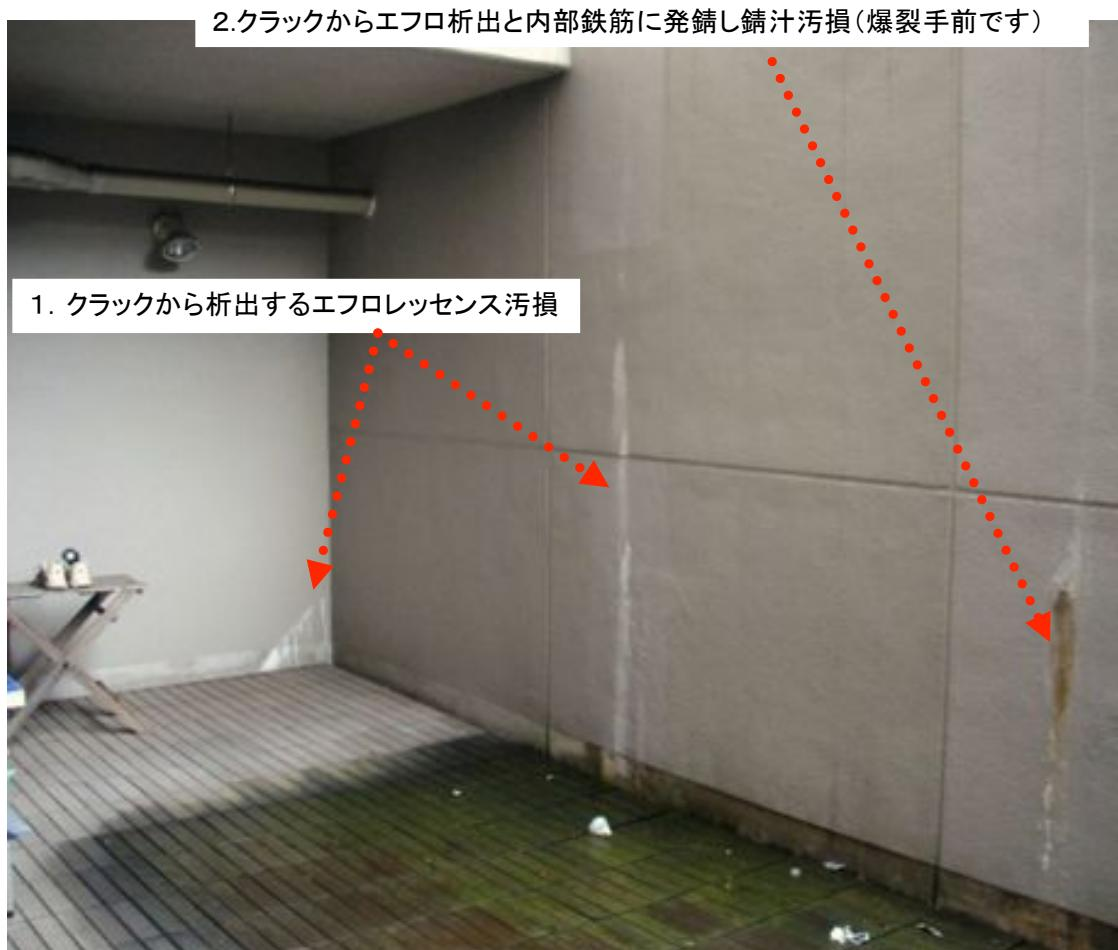
②-4. 占有バルコニー外周壁梁躯体に発生するタイル剥落に至る漏水とタイル浮き事例です。
