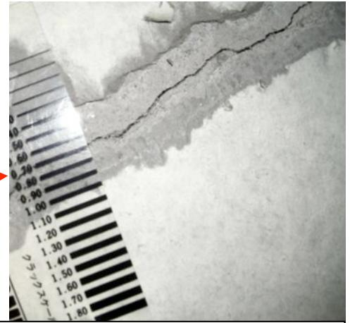
住居内戸境壁の壁紙に薄く線や皺が発生し、この居室オーナーから指摘を受け、壁紙を剥がしクラックを露出させ位置・長さ・幅等を確認した後に補修
