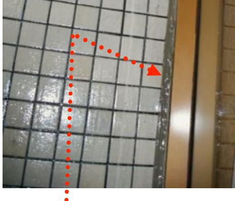
\* 縦目方向シールに何箇所も膨れで見える部位は、裏面の漏水が弱い部位を押している状況です。
